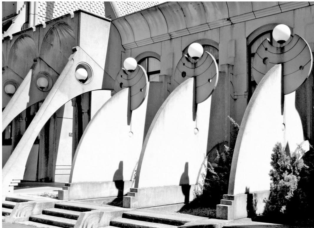
Прогрессивный сборный железобетон Плас Пикассо
