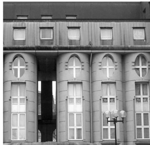
Сборные железобетонные элементы эркера, примененные для жилого комплекса Плас Пикассо в Нуази-ле-Гран и жилого комплекса Балкон де Кламар в Париже
